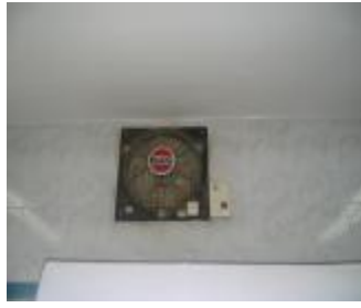
صور توضح تركيب مراوح التهوية في الجدار الداخلي والسقف مع مفتاح تشغيل
