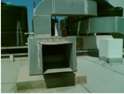
صور توضح شكل المجاري الهوائية (Grille) المصنوعة من الكرتون المقوى على شكل (أنابيب زنبركية).
