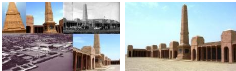
● مركز الشرطة:- صمم هذا المبنى من قبل مهندسو الموانئ في سنة 1928 في منطقة المسفن في المعقل. النظام الانشائي المكون من الجملون الحديدي المستخدم في التسقيف الذي يتكون من مسمنين. استخدمت القواطع في تقسيم الفضاءات الداخلية (partition wall) لتتوزع الفضاءات على جانبي محور مركزي. يحيط الواجهة المطلة على النهر (الامامية) والواجهة المطلة على المسفن (الجانبية) على رواق معمد تضمن المبنى جزءاً خصص لمكتب مقاولات مديرية الموانئ العامة [24،ص112]. شكل (7)
